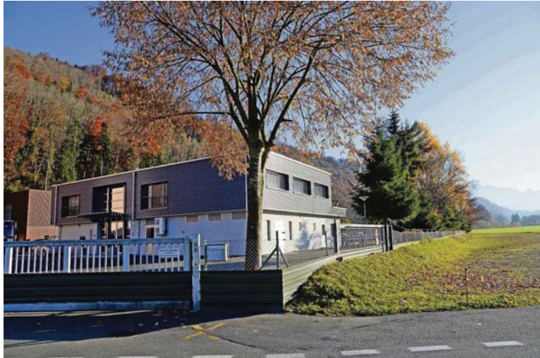
Rechts neben dem Betriebsgebäude in Alpnach entstehen die neuen Becken.
